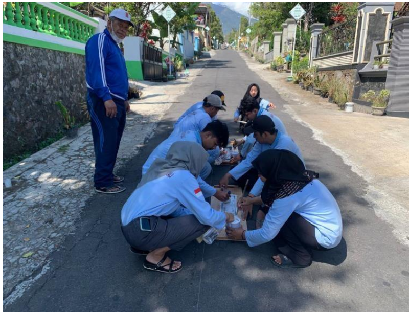
Gambar 2. Pengecatan Marka
